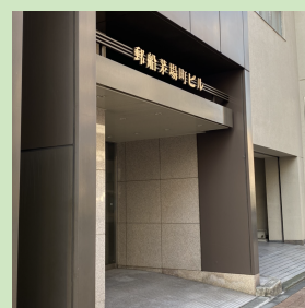
JP 茅場町ビル入口
